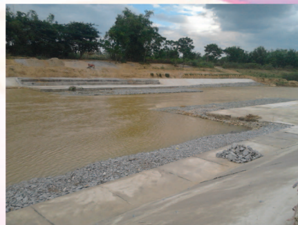
Công trình điều tiết lưu lượng mùa kiệt trên hệ thống sông Vu Gia - Thu Bồn
