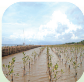
Tường mềm giảm sóng, gây bồi và trồng cây ngập mặn bảo vệ đê biển, bờ biển Sóc Trăng
