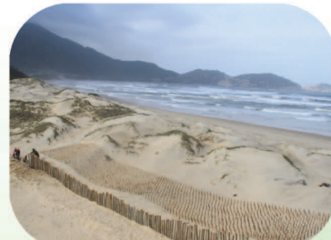
Công nghệ bẫy cát có định hướng bằng cọc gỗ để liên kết các giồng cát thành đê biển tự nhiên
